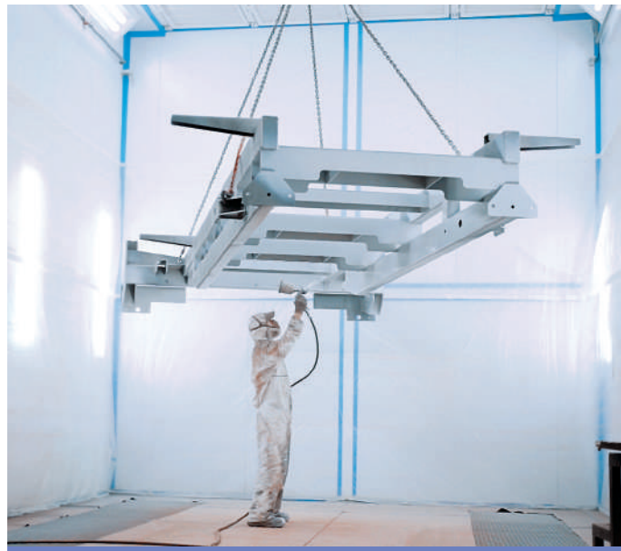
Для крупногабаритных металлоконструкций
