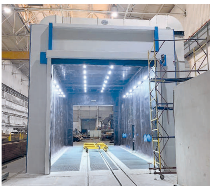
Для крупногабаритных металлоконструкций
